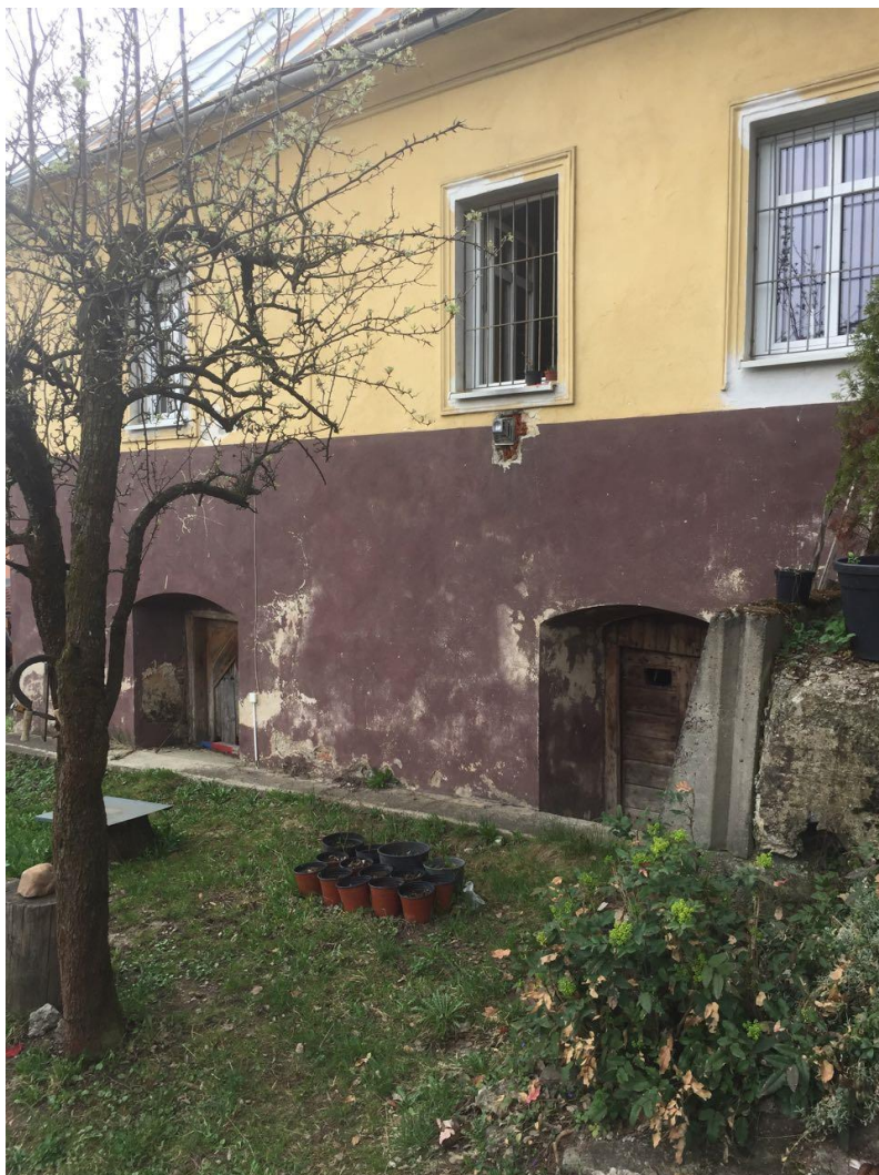
opadaná fasáda na budove
