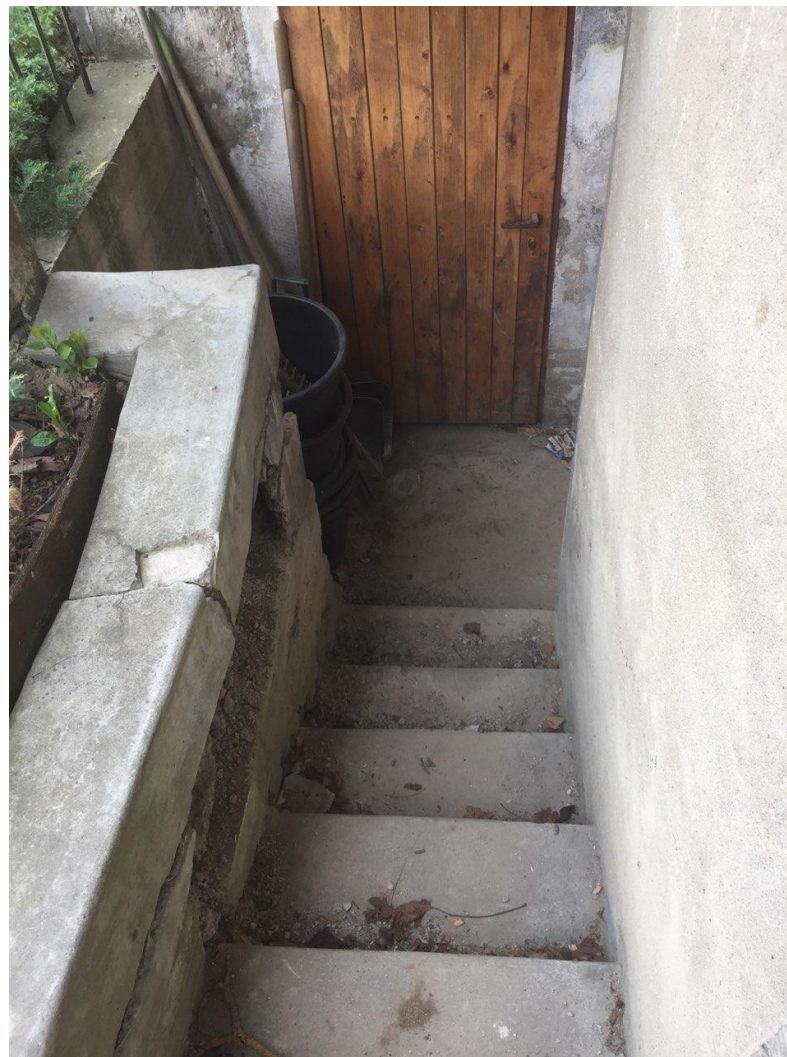
popraskaný oporný múrik
