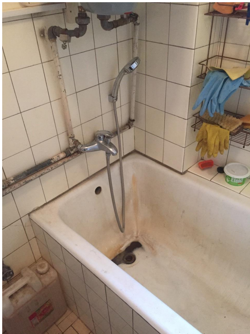
stará vaňa nevyhovujúca hygienickým normám
