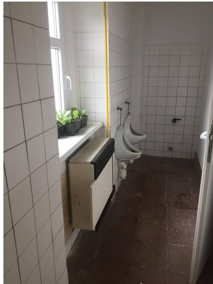
nefunkčné výhrevné telesá na kúrenie
